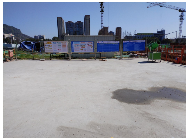
厂区硬化措施
