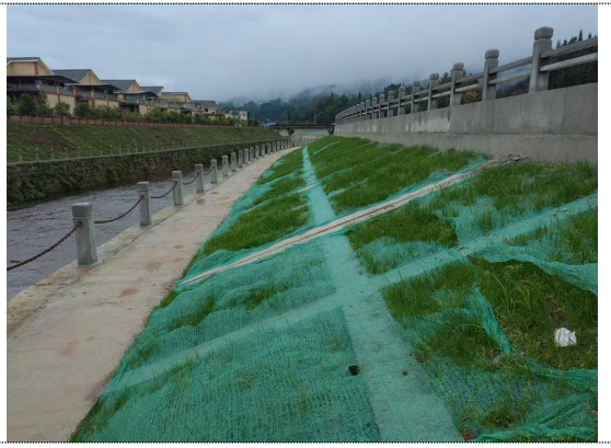
严桥河堤防（2024 年 4 季度）
