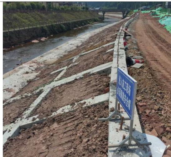
严桥河堤防（2024 年 3 季度）
