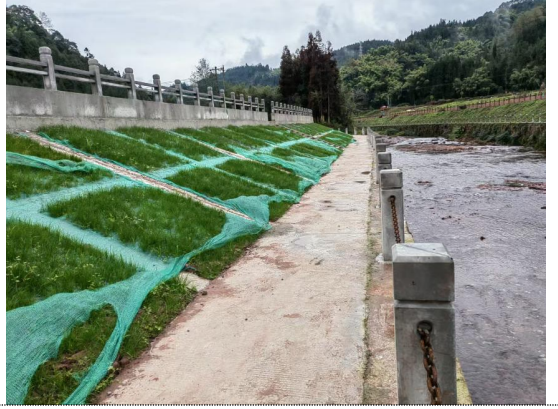
严桥河堤防（2024 年 4 季度）
