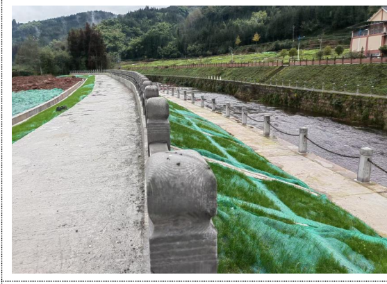
严桥河堤防（2024 年 4 季度）
