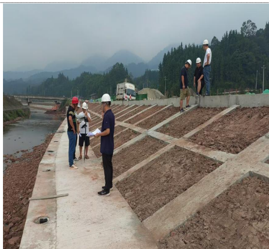
严桥河堤防（2024 年 3 季度）
