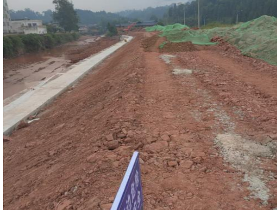
严桥河堤防（2024 年 3 季度）
